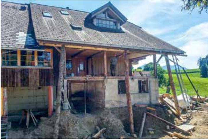
*Für den Anbau musste das Dach und die oberen beiden Stockwerke abgestützt werden*
