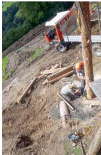
Das Haus wird abgestützt. Zuschauen ist immer spannend
