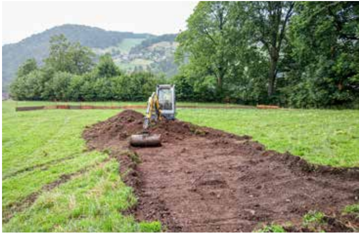
Beginn der Vorbereitung der Fläche für den Aushub
