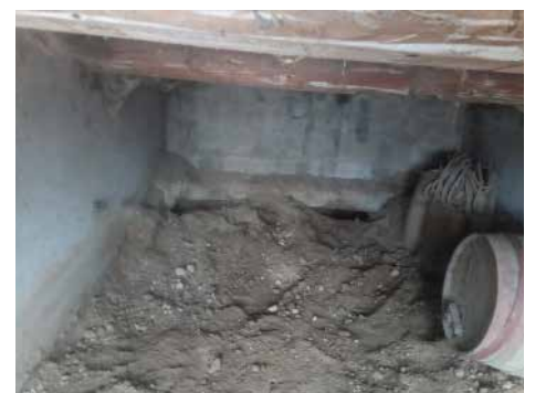
Nachher, ganz hinten das Loch in den Dachsbau; im Moment schläft er wohl drin.
