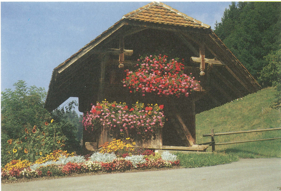
Abb.29 Speicher der Höhenklinik, erbaut 1788.
